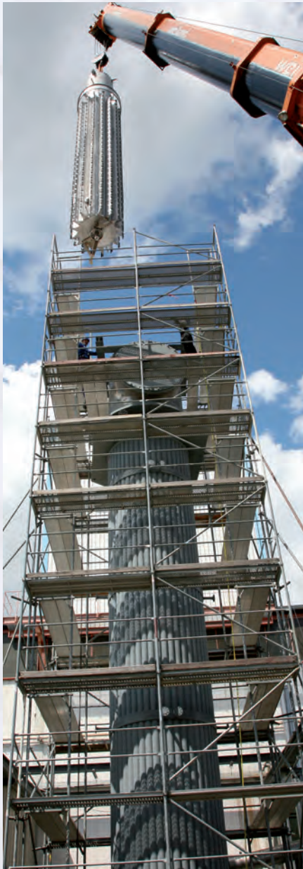
Монтаж сушильного аппарата СР
